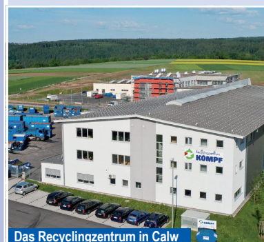
Das Recyclingzentrum in Calw
