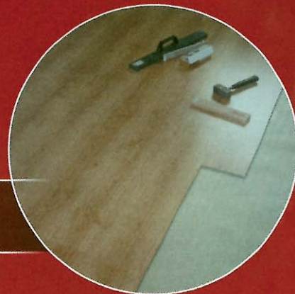
Fußbodenverlegung Parkett, Laminat & Kork
