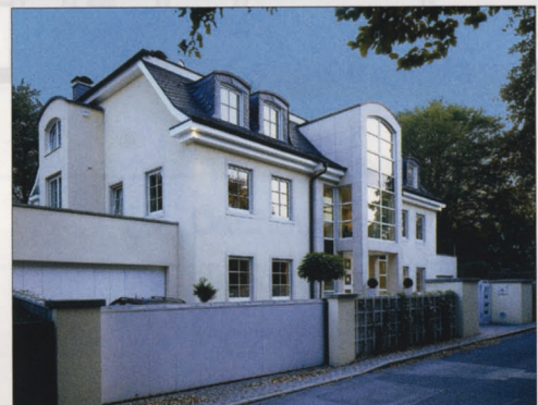
Bömbergring 107 • Einfamilien-Wohnhaus 12 Monate Bauzeit
