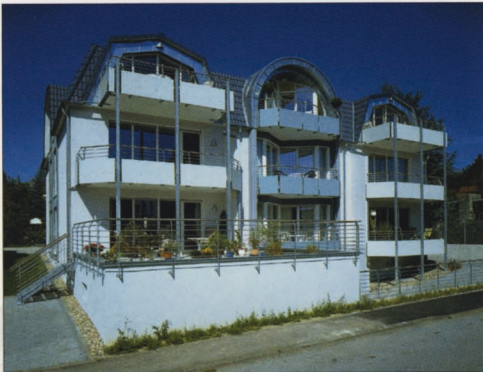
Bömbergring 17a • 9 Wohneinheiten 10 Monate Bauzeit
