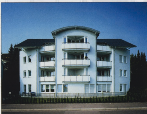
Berliner Allee 101 • 11 Wohneinheiten 10 Monate Bauzeit
