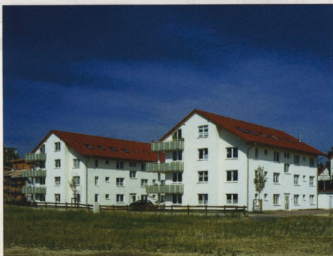
Oestricher Str. 9-37 • 5 Wohnhäuser mit 44 Wohneinheiten • 12 Monate Bauzeit
