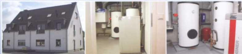
Brauchwasser- und Heizungswärmepumpe mit Luftkondensator energiesparend für den privaten Bereich.
