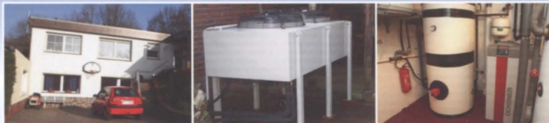
Brauchwasser- und Heizungswärmepumpe mit Luftkondensator energiesparend für den privaten Bereich.
