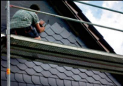
Das Naturprodukt Schiefer eignet sich durch optimalen Wetterschutz, lange Haltbarkeit und ansprechende Optik hervorragend zum Eindecken ganzer Dächer sowie zum Verkleiden von Gauben, Giebeln und hinterlüfteten Fassaden.
