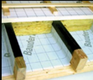
Die wannenförmig über die Sparren verlegte Dampfbremse muss einerseits stark feuchtigkeitssperrend und andererseits diffusionsoffen sein.
